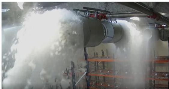
Essai extinction automatique mousse
